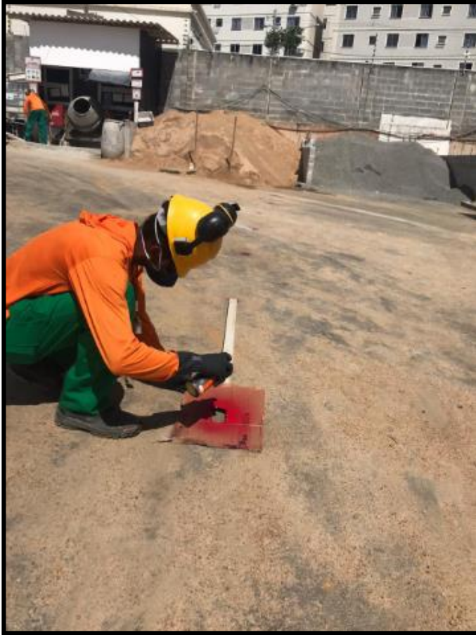
Marcação do distanciamento de 1m para bater ponto
